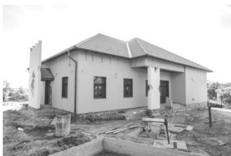
Foto.: Modernizare si extindere camin cultural loc.Bontaieni
