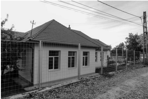
Foto.: Modernizare si extindere Scoala Gimnazială din Cetatele
