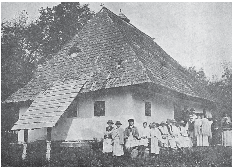
Casa în care a locuit Vasile Lucaciu renovată
